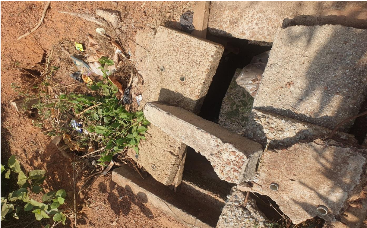
Figure 1: Quelques images illustratives des regards effondrés.
