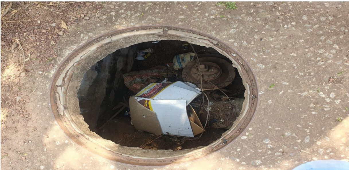
Figure 2: Les images illustratives des regards dépourvus des couvercles en face du Rectorat de l'Université de Bertoua
